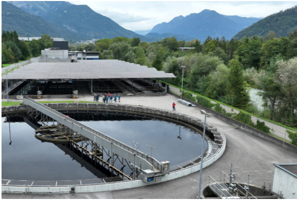
Mehrfacher Nutzen eines PV-Dachs: Eigens produzierter Solarstrom senkt die Energiekosten, die Beschattung belüftet und sorgt für geringere Temperaturschwankungen und Algenbildung.
